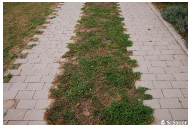
Teilschotterrassen – wasserdurchlässiger Belag mit höherer Wasserspeicherfunktion im Vergleich der Belagsarten
