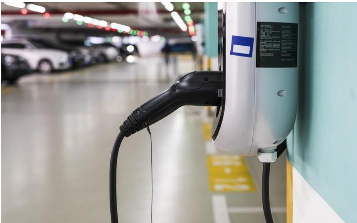
Abbildung 7.2: Wallbox für Pkw in Tiefgaragen, derzeitiger Stand der Technik
