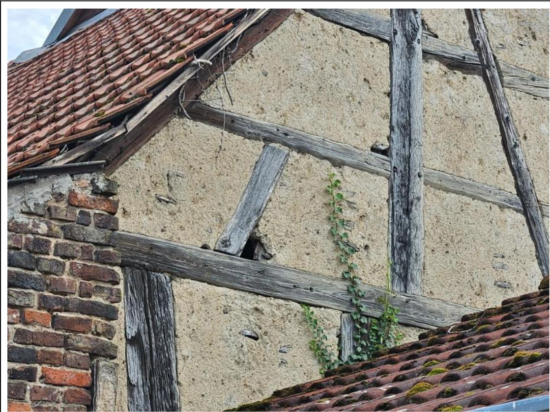
Abbildung 9: Fachwerk-Giebelseite mit losen Ziegeln, Wandöffnungen und Hohlräumen
