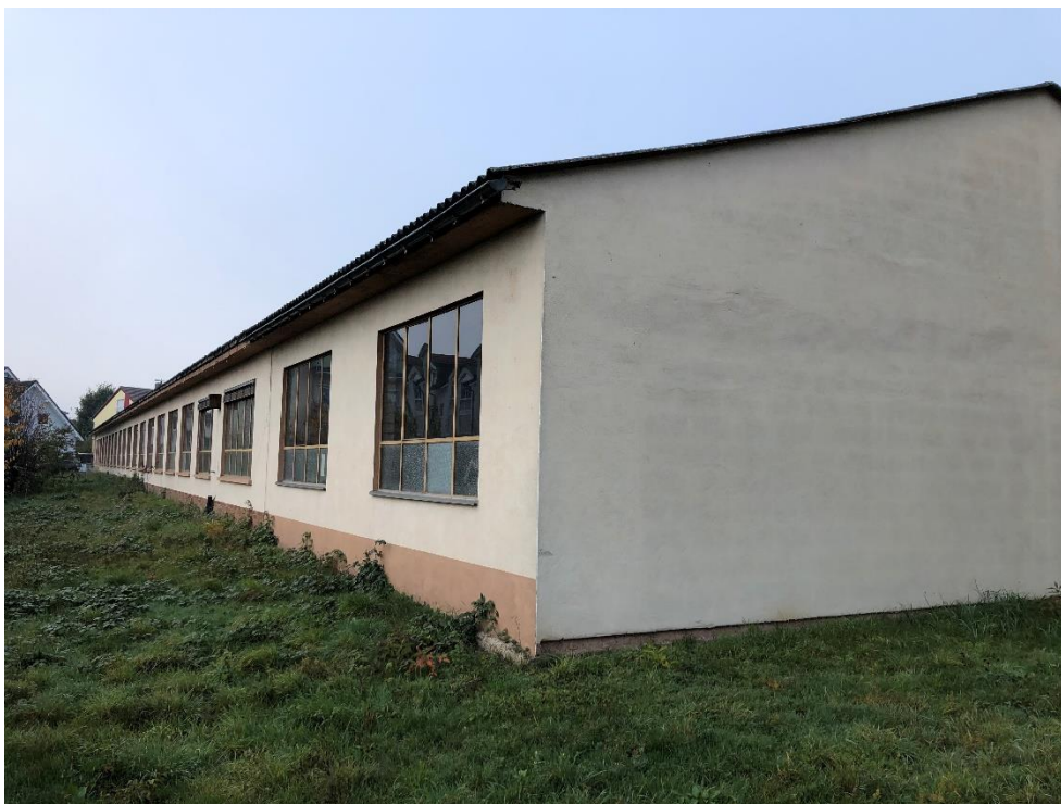
Abb. 2: Die Südseite der Lagerhalle, 13.11.2019
